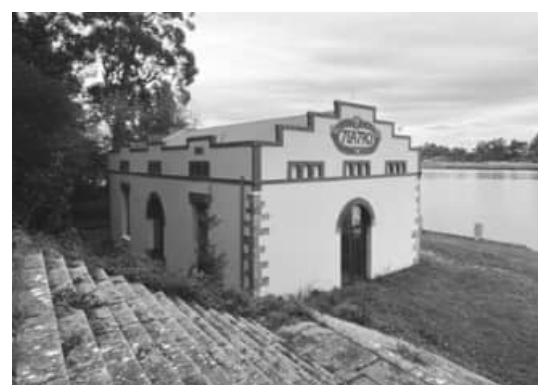
Estado actual del teatro, en mayo de 2025.
